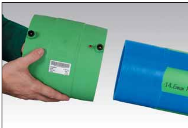
Nataknuti E-spojnicu na kraj cijevi
