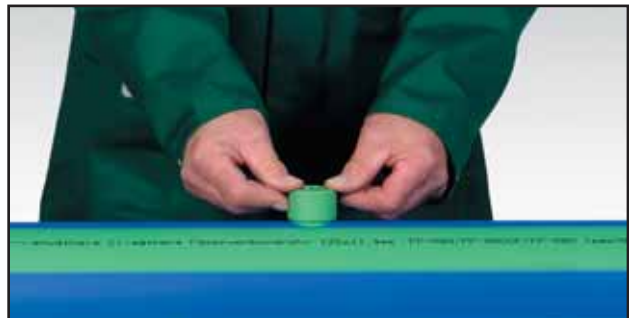
Spajanje i učvršćivanje elemenata
