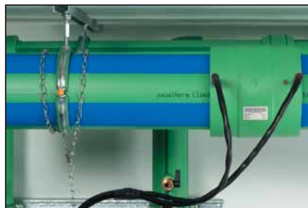
Aparat za zavarivanje podesiti na promjer spojnice. Pokrenuti postupak zavarivanja. Pridržavati se vremena hlađenja. Gotovo!
