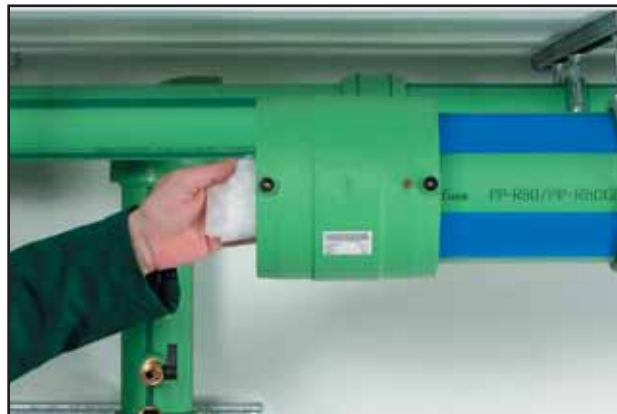
E-spojnicu još jednom očistiti
